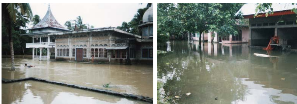
Gambar 2.1. Kondisi Banjir di Kab. Padang Pariaman
