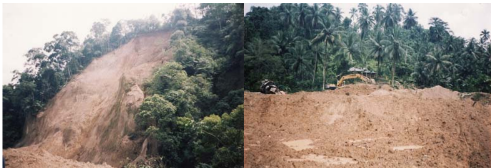
Longsor di Bukik Takurung Aia Janiah Talao Nagari Kudu Gantiang Kec. V Koto Timur (Dokumentasi : Kantor Lingkungan Hidup Kab. Padang Pariaman, 2007)
